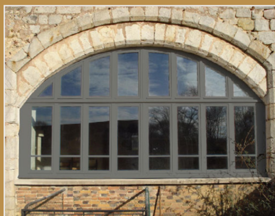
Menuiserie dans une ouverture cintrée
