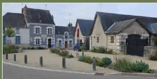
Simplicité des matériaux et revêtements, mobiliers (bornes bois, banquettes sur muret) limités à leurs usages, place de la voiture cadrée, végétation permettant l'infiltration des eaux pluviales : une conception globale. Place de la mairie, Le Louroux (37)
