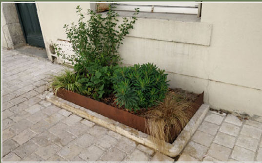
Massif de vivaces en pleine terre, les bordures permettent de contrôler l'infiltration en pied de mur. Cognac (16)
