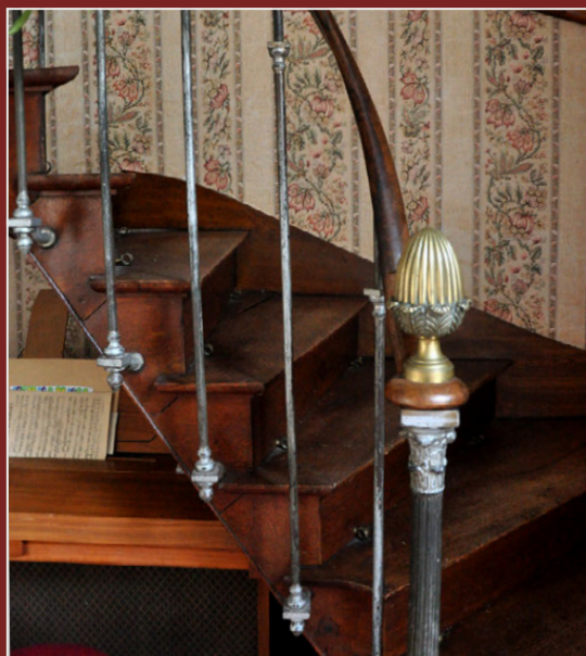
Escalier et main-courante
