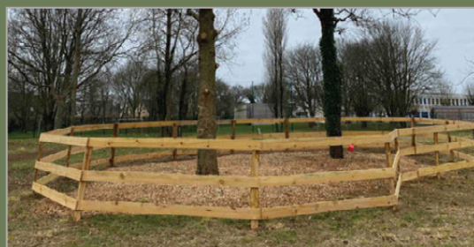
Protection des arbres lors des chantiers
