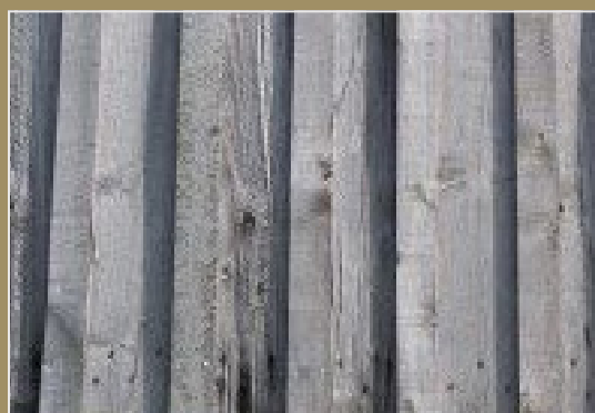
Bardages à litaux couvre-joints
