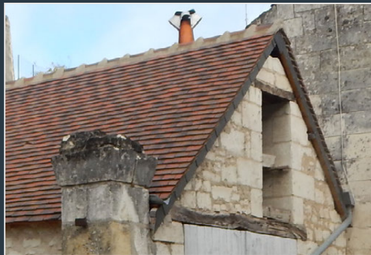
Couverture en tuiles plates
