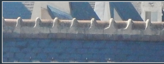
Faîtage à crêtes et embarrures sur rang de tuiles
