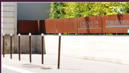
Exemple de mur bahut contemporain
