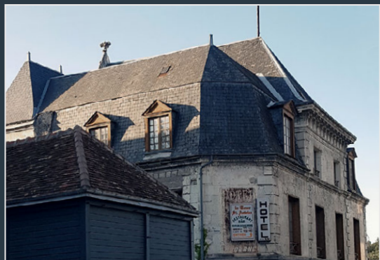
Couverture en ardoises
