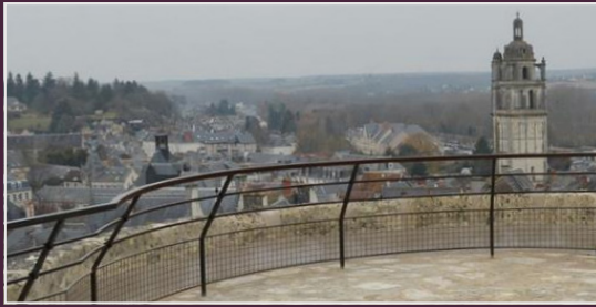
Modèle de garde-corps à emprunter en cas de besoin sur le rempart
