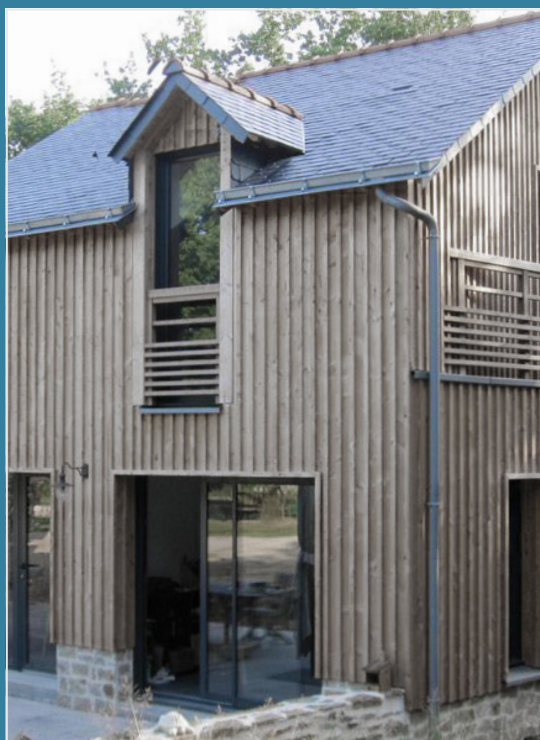
Exemple d'isolation par l'extérieur
