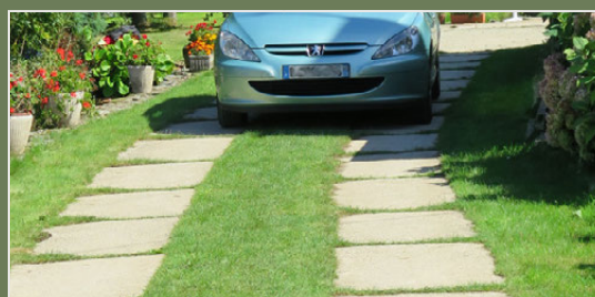
Exemple de revêtement perméable : dalles de pierres (ou béton) à joints enherbés, pour les circulations automobiles
